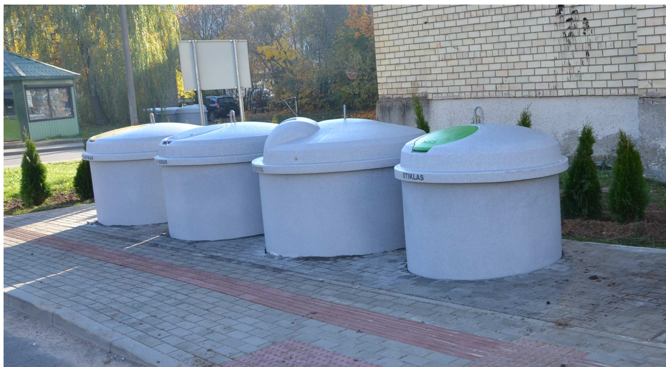
Pav. Nr. 1 pusiau požeminių konteinerių aikštelė (Šalčininkų savivaldybės nuotrauka)
