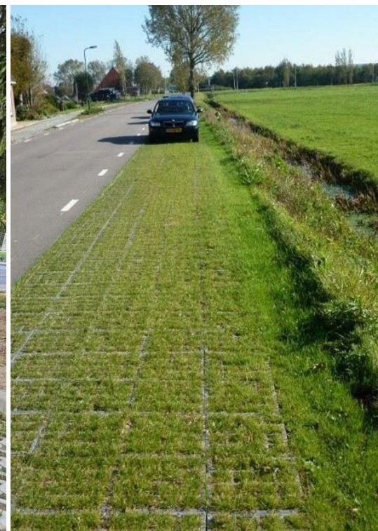
23 pav. Betono trinkelių korio danga su augalinio sluoksnio užpildu ir pasėta trypimui atsparia veja automobilių stovėjimo aikštelėje šalia futbolo stadiono Bukčių gatvėje, Vilniuje. Nuotrauka autorių, 2024
