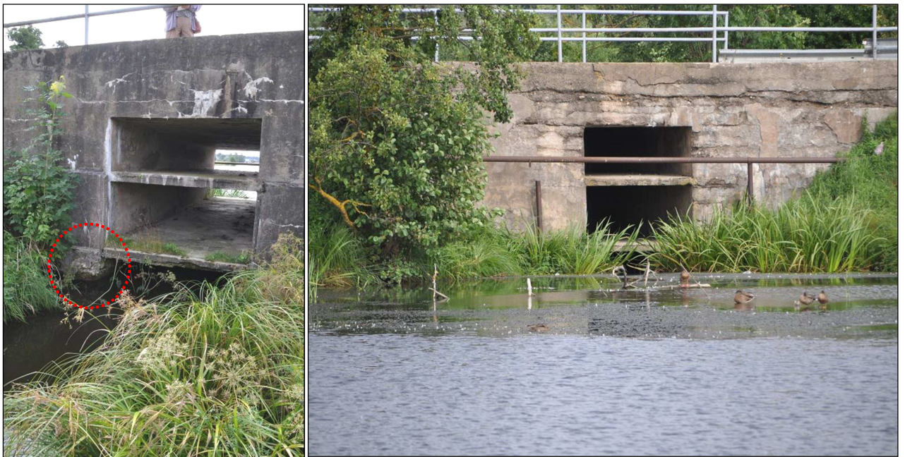
28 pav. Įtekėdama į Šalčininkų I-ąjį tvenkinį, Šalčia prateka stačiakampę trikampę pralaidą (A. Balevičiaus nuotr.)
