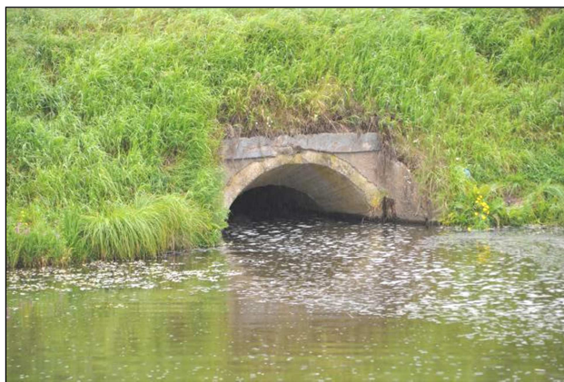
29 pav. Šalčininkų I-ojo tvenkinio šachtinė pralaida ir ištekėjimas kitoje Nepriklausomybės g. pusėje (A. Balevičiaus nuotr.)
